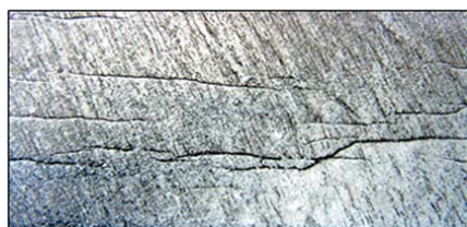
Рис. 1. Трещины КРН на ЛЧМГ
